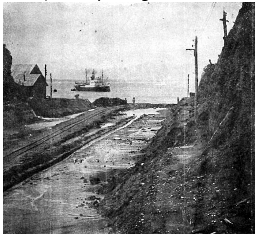
Imagen 5: Trabajos en la puerta granítica del Istmo de Ofqui.
